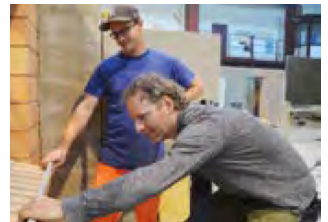
Instruktor Roman Högger (vorne) überprüft das vom Frauenfelder Maurer Dominik Meier erstellte Sichtmauerwerk.
